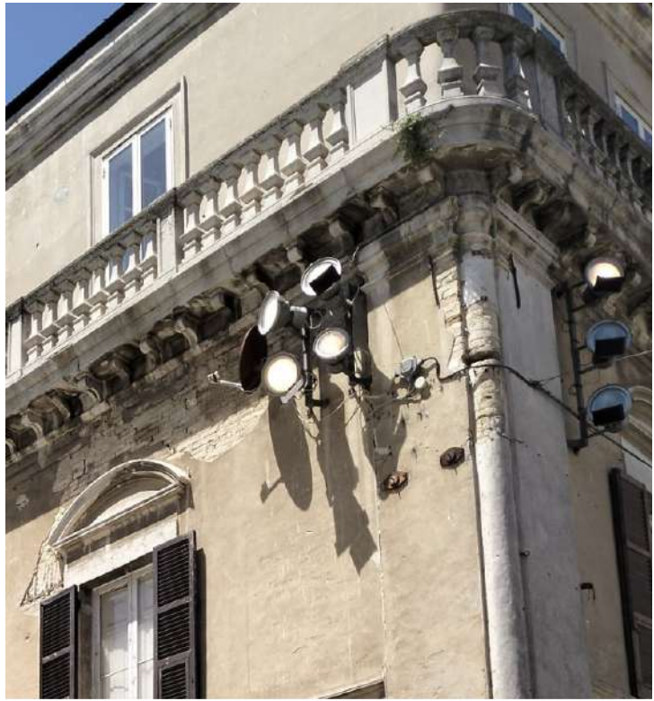
Proiettori esistenti posti frontalmente alla facciata principale del palazzo
