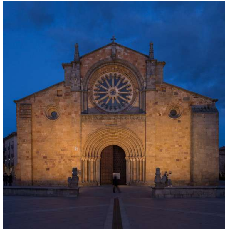
Rif. 1 - Illuminazione della facciata con luce bianca
